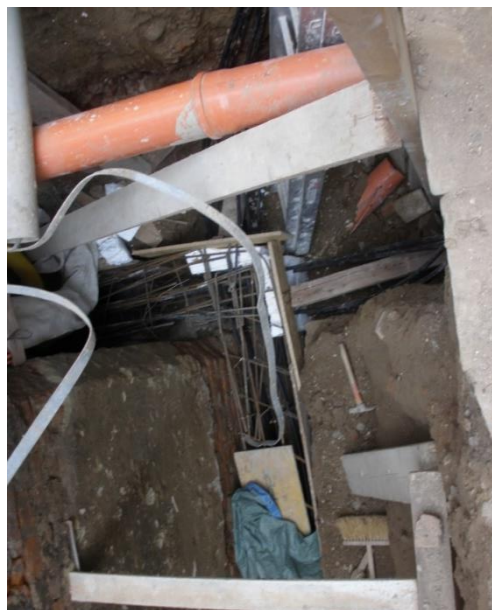
Obr. 5 Uložení výztuže předpjatých základových pásů (příčný a podélný) na rohu objektu (hloubka základu cca 3,0 m pod terénem)
