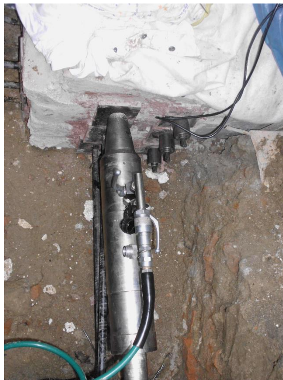
Obr. 9 Detail postupného napínání šestice lan v nároží pomocí jednonarové pistole.
