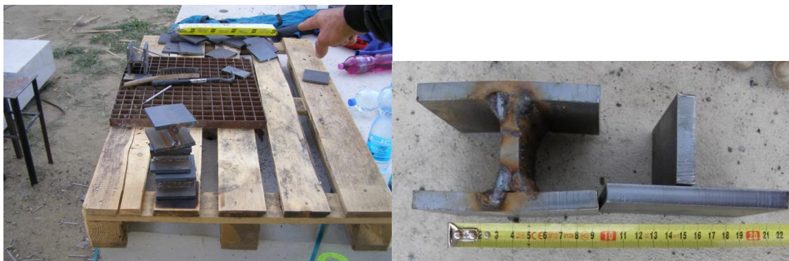
Obrázek č. 5: Svařování distančníků na stavbě a detail vyrobeného distančnicku
