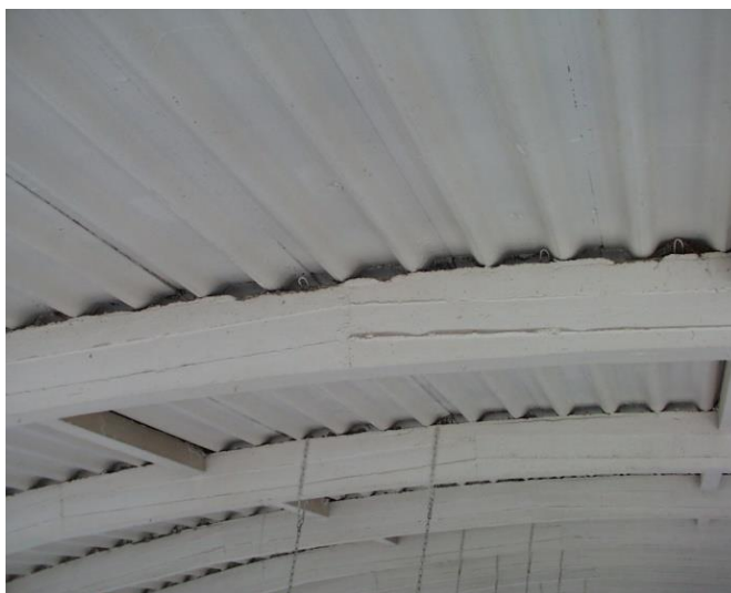
Obr. 2: Uložení desek na železobetonové vazníky, Brno výstaviště
