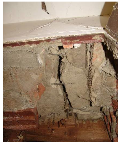
f) Typ poškození 7 - detail
