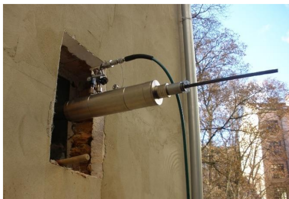
Obr. 12 Osazení předpínacího lisu při napínání lana
