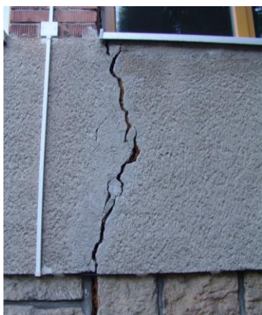
a) Typ poškození 1 a 2
