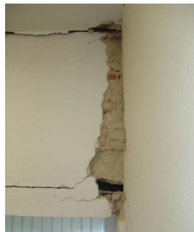
c) Typ poškození 4
