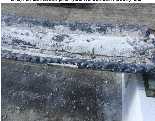
Obr. 9: Poškození desky D3
