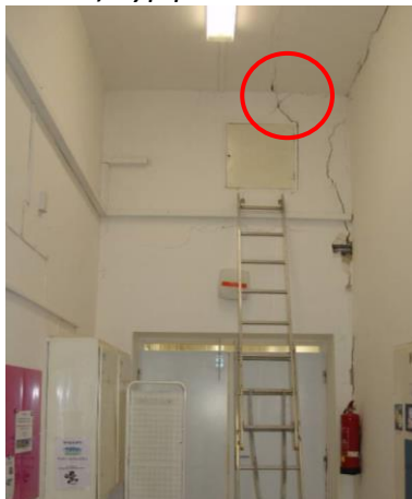
e) Typ poškození 7
