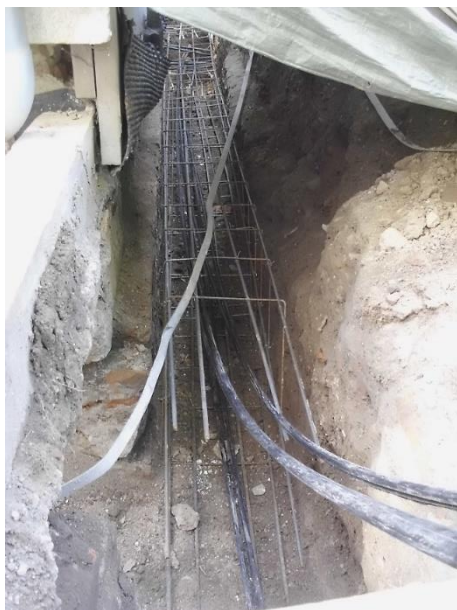
Obr. 4 Příprava armokoše s protaženými předpínacími lany
