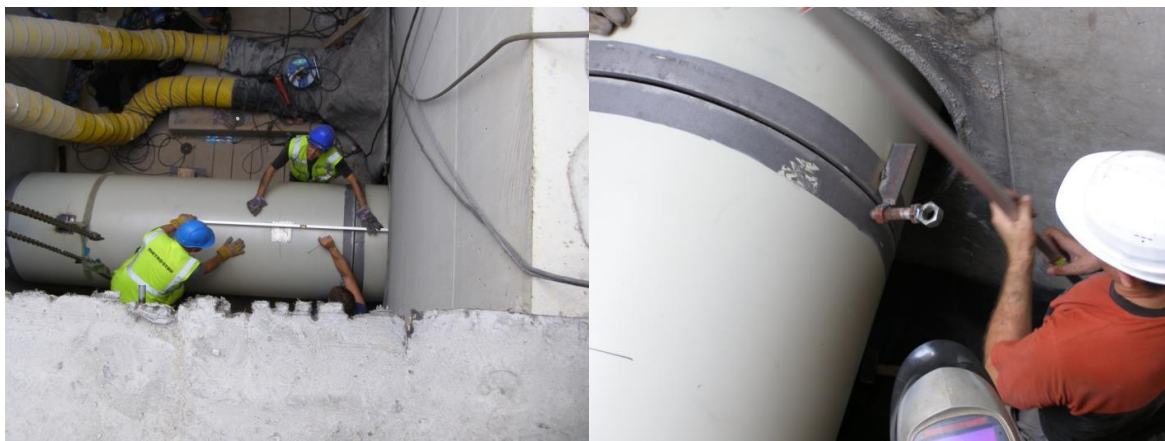
Obrázek č. 9: Rektifikace polohy navazujících trubek před realizací montážního svaru
