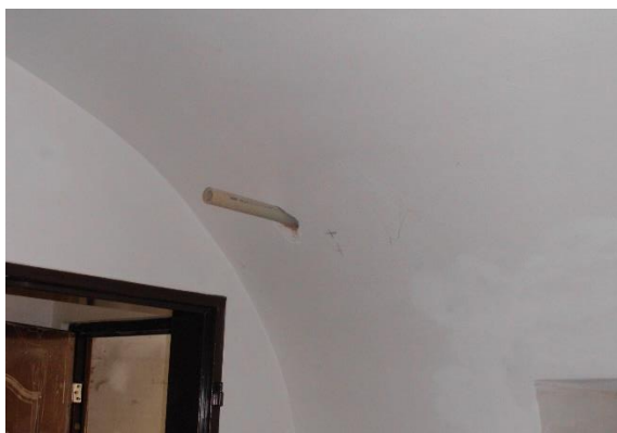
Obr. 11 Provrtání kanálku pro vedení lana – pohled v interiéru
