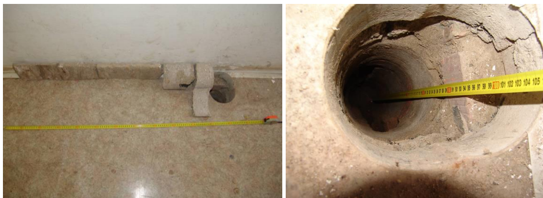
Obrázek 4.: Vrtaná sonda „B“ k základovým konstrukcím chodbové dělicí příčky.
