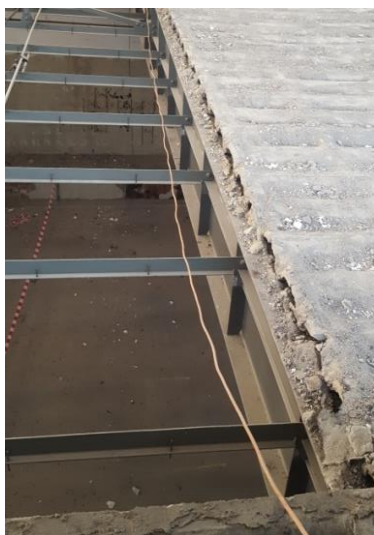
Obr. 1: Uložení desek na ocelové vazníky, rekonstrukce Janáčkova divadla Brno
