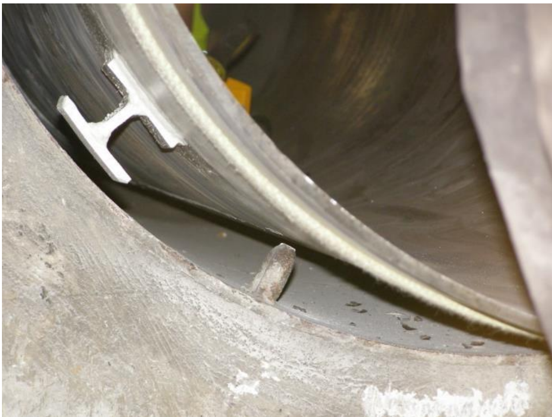
Obrázek č. 8: Detaily distančníků při posuvu trubky DN 1000 do chráničky DN 1200
