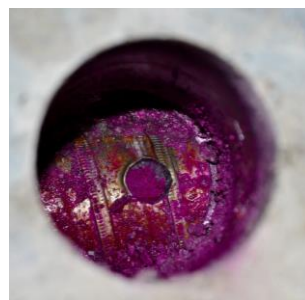
Obrázek 7.: Návrt k ocelové chráničce, vylomení vývrtu a průraz chráničky až ke kabelu. Současná běžná praxe kontroly.
