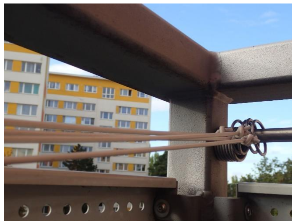
Obrázek 3.: Detail připojení rohového sloupku k madlům balkonu
