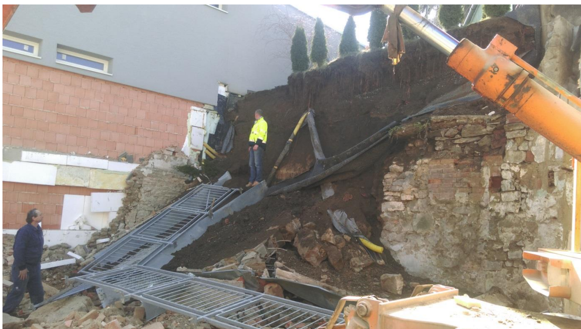
Obr. 2 Stav po zřícení zdi. Ve spodní části patrné původní jílovité podloží, v horní části zvýšení terénu humusovitou hlínou
