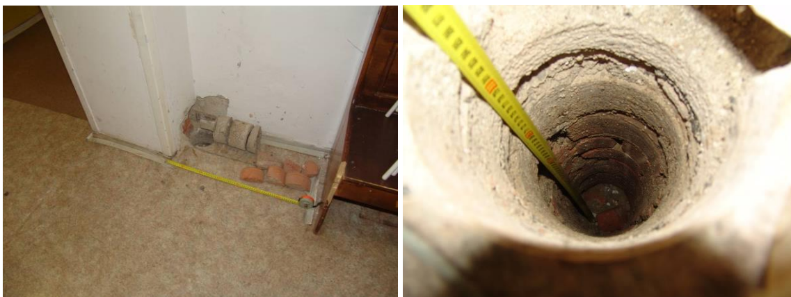
Obrázek 5.: Vrtaná sonda „C“ k základovým konstrukcím pilíře ztužujícího rámu příček a dělicí chodbové příčky.
