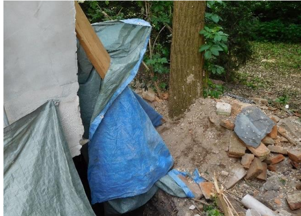
Obr. 3 Základy nepříznivě ovlivněny kořeny stromů
