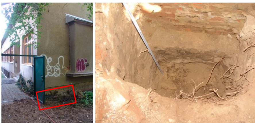
Obrázek 6.: Kopaná sonda „A“ k základovým konstrukcím obvodové štítové stěny s arkýřem v rohové části objektu přístavby.
