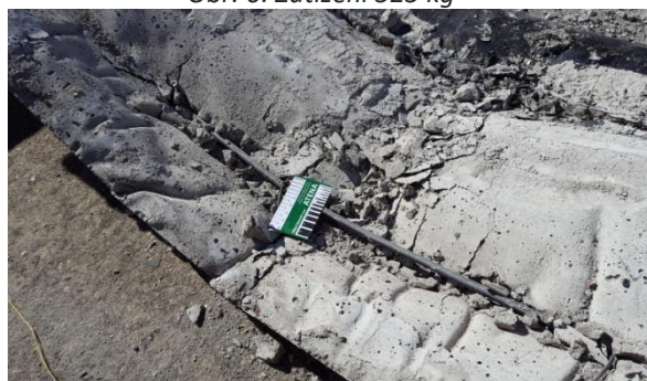
Obr. 8: Zjišťování vyztužení desky
