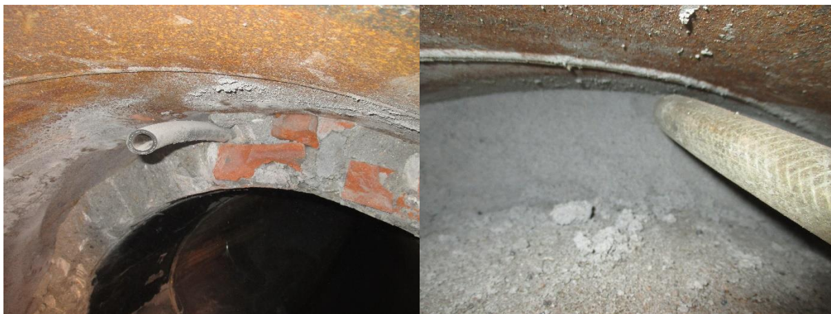
Obrázek č. 4: Detaily instalovaných odvzdušňovacích hadiček na rozhraní zdivo čela – injektážní ztvrdlá směs, vnitřní průměr hadičky maximálně 25 mm
