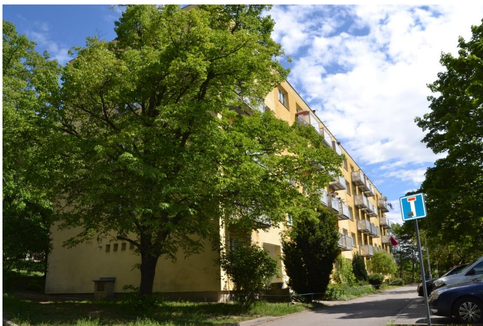
Obr. 1 Pohled na sledovaný panelový dům na ulici Krásného v Brně.
