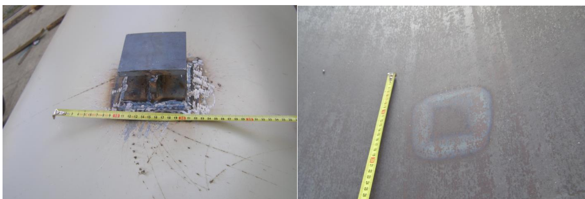
Obrázek č. 6: Detail navařeného distančnicku na vnějším plášti a stav vnitřního pláště pod distančnickem po navaření
