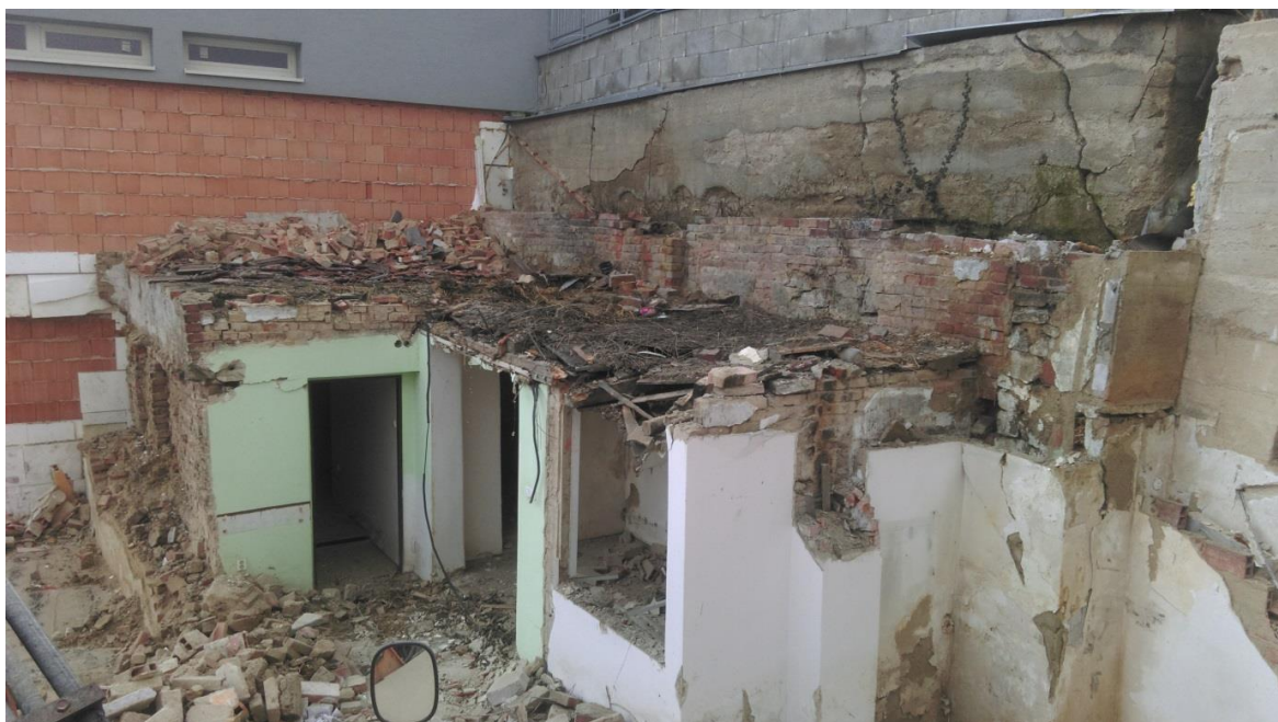
Obr. 1: Stav před zřícením zdi. Ve spodní části zchátralé přístavky, ve střední části silně trhlinami narušená a vykloněná betonová zeď, nahoře zděné nadvýšení. Problematické zvýšení původního terénu od paty betonových zdí
