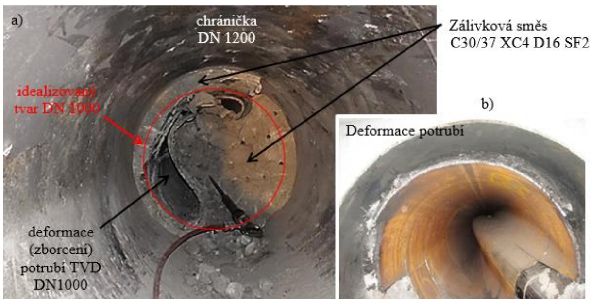
Obrázek č. 3: Charakter zborcení potrubí TVD 2 při pohledu z chráničky (foto pořízeno při místním šetření dne 7. 8. 2015 v průběhu demontážních prací)
